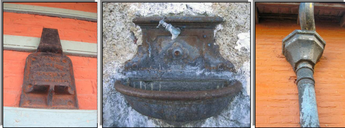
Figura 15 Trabajos en hierro
