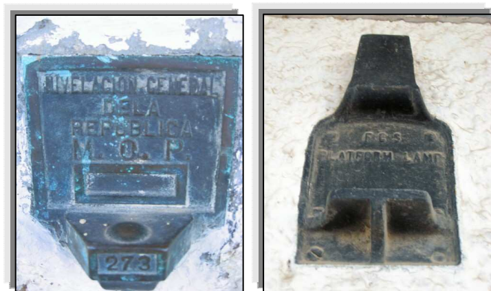
Figura 19 Trabajos en hierro
