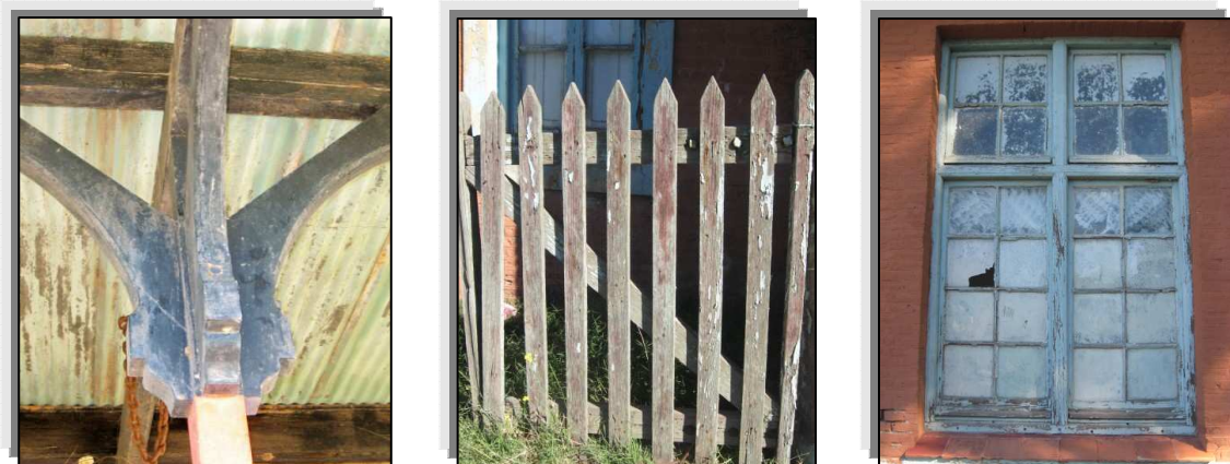
Figura 14 Carpinterías de madera
