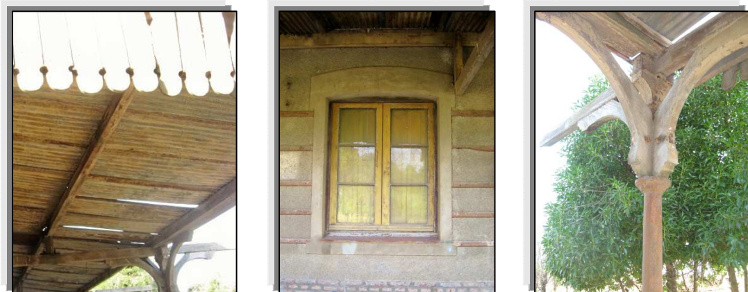
Figura 23 Carpinterías de madera y estructuras en hierro
