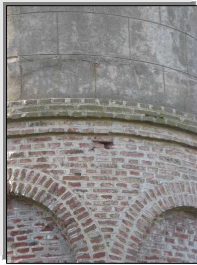
Figura 29 Tanque de ladrillo visto
