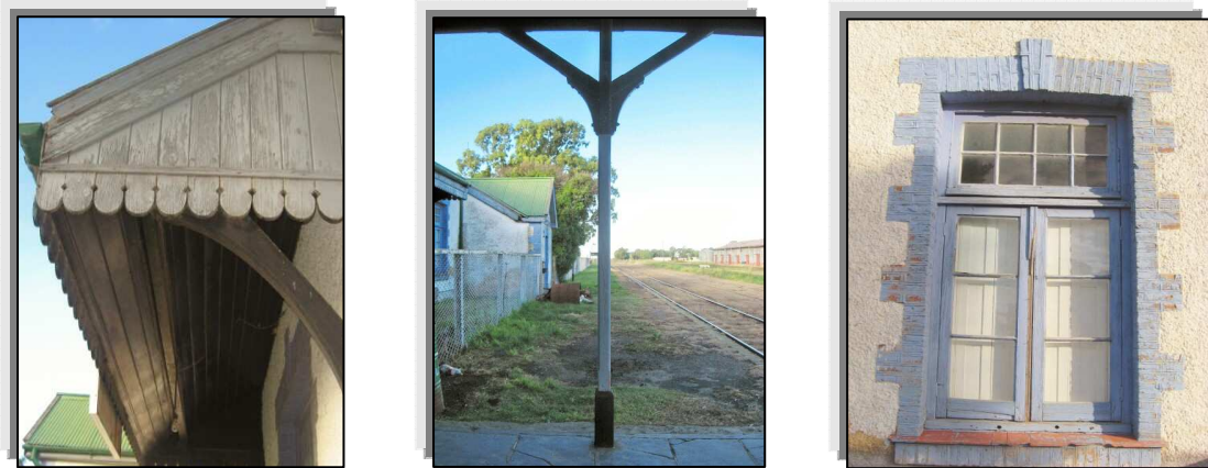
Figura 18 Carpinterías de madera
