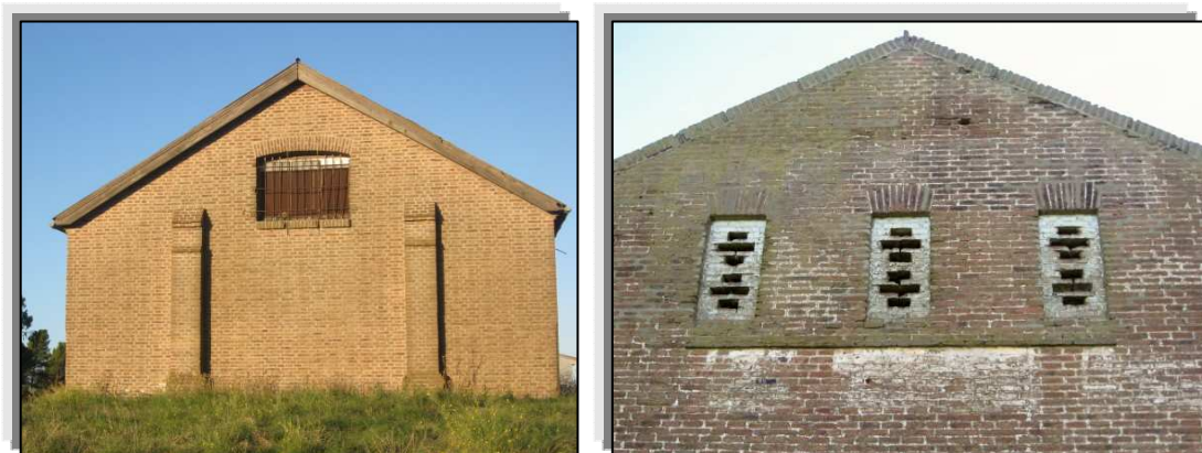
Figura 27 Depósito de ladrillo visto
