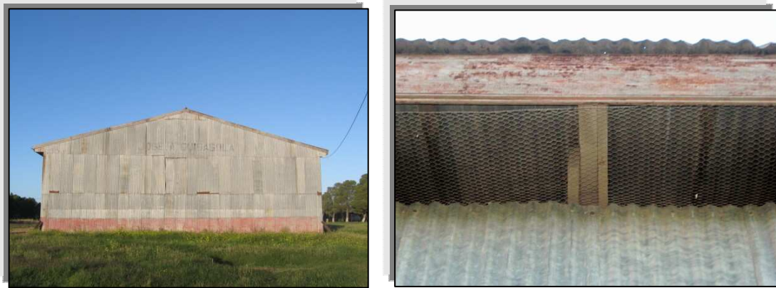
Figura 26 Depósito de chapa
